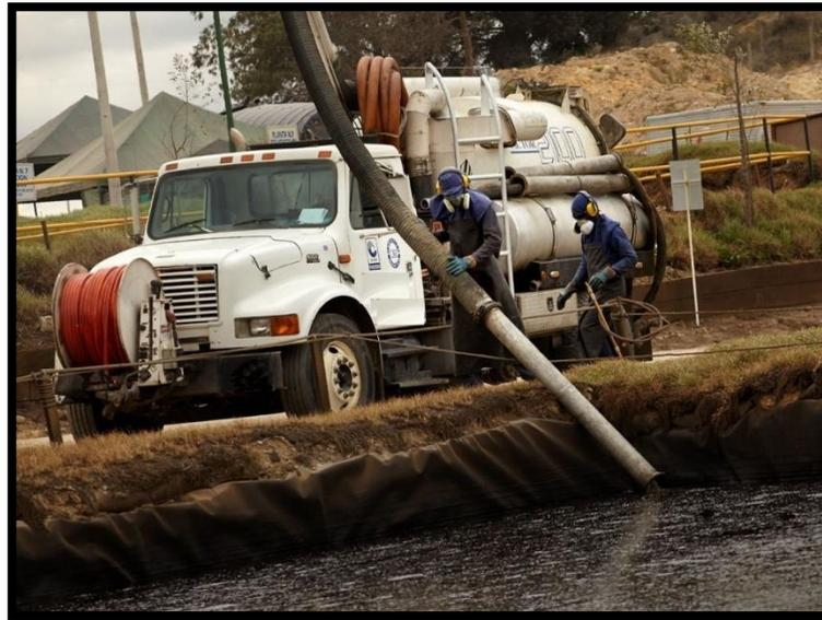
El tratamiento de lodos consiste en un proceso completo que incluye fases de estabilización, homogenización, deshidratación sin adición de químicos ni el uso de centrifugas ni filtroprensas y por último la mineralización, logrando como producto final un sustrato que sirve como remediador de suelos.
